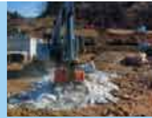
①中越地震で発生した軟弱土をボンテラン工法で改良
