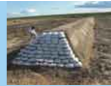
④仙台市若林区藤塚の農地で津波堆積物の再資源化による人工地盤造成
